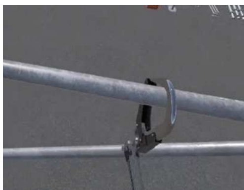
安全帯を正しく使用しないで歩き出すと、足場から落下する
