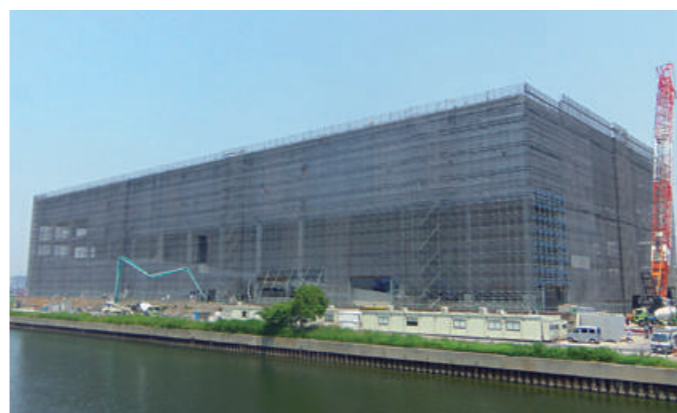
大規模物流センター 長大躯体でも大組み・大払いで効率的な施工が可能
