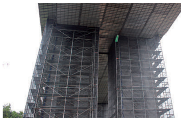
高速道路橋脚 上部工つりだ足場SKパネルと組み合わせて設置
