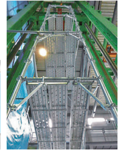
支柱強化の荷重試験
